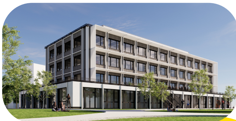
Image illustrative – chantier en cours
